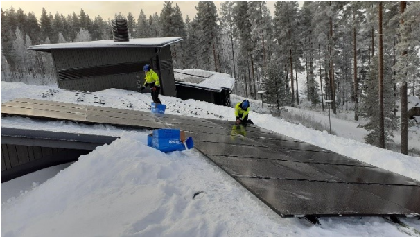
Aurinkopaneelien asennusta Susiniemen leirikeskuksessa
