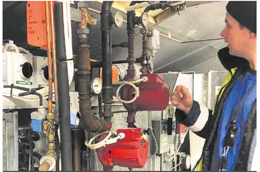
Ecool-hankkeen projektityöntekijä, energiakatselmoija (LVI) Niko Myllyviita tarkastelee seurakuntakeskuksen ilmanvaihtojärjestelmää.
